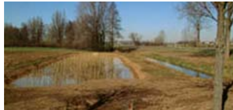
Helofytenfilter als zuiveringsmoeras
