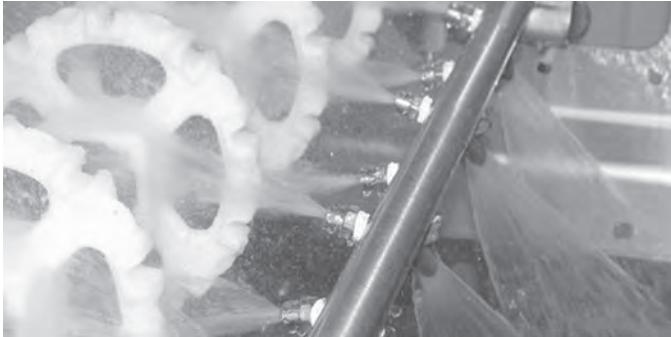
Figura 164: Il modello di spruzzatura è progettato specificamente per pulire la superficie inferiore del nastro, i pignoni e l'albero.
