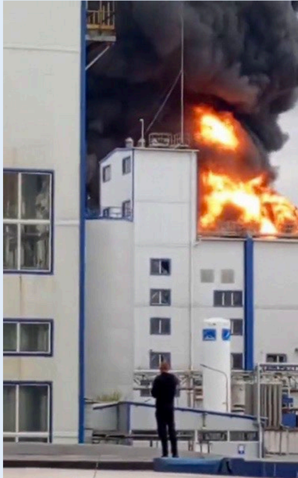
Imagen 1. Incendio en Extractora de aceite vegetal en Odessa.
