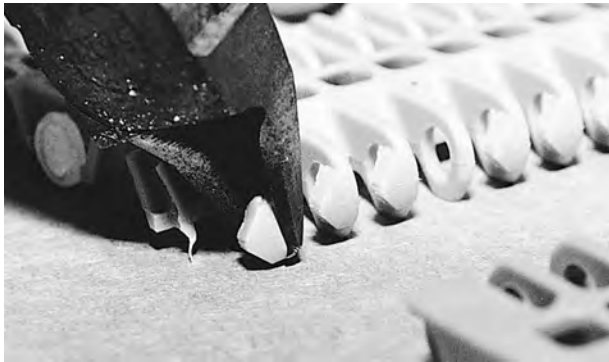
Figur 33: Kutt spissen av avstandsholderen
