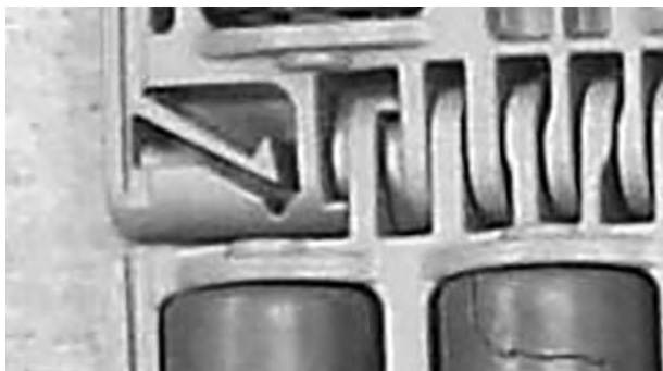
Figur 224: Sørg for, at stangen er forbi låseanordningen
