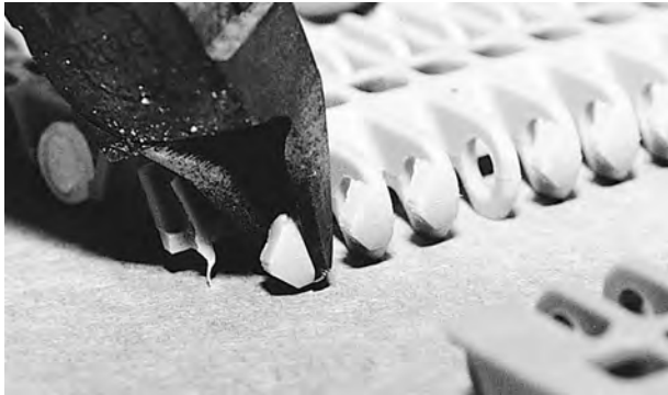
Figure 33: Coupez l'extrémité du cône d'espacement
