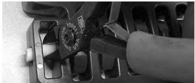
**Figura 338:** Spingere il perno lateralmente e oltre il foro chiuso
