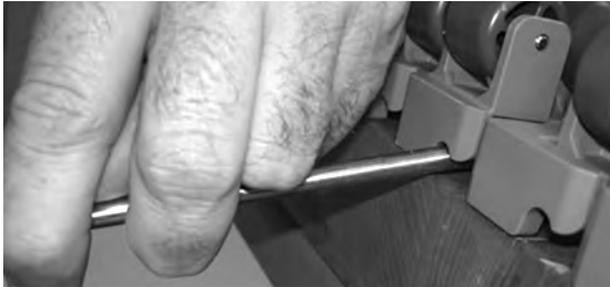
**Figura 194:** Inserire il perno in acciaio nella cerniera
