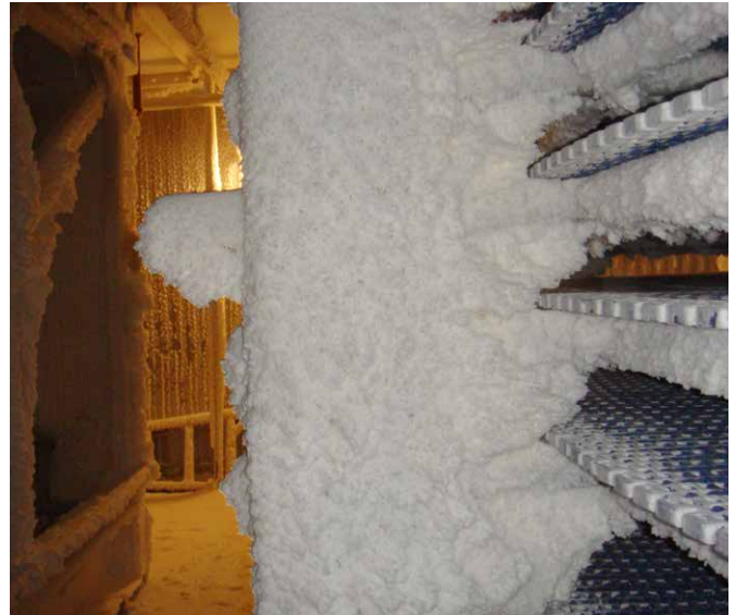
L'accumulation de glace limite la vitesse du flux d'air, réduisant ainsi l'efficacité du système.
