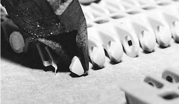
**Figura 33:** Corte a ponta do espaçador
