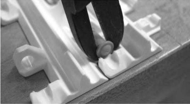
**Figura 183:** Cortar la cabeza de la varilla
