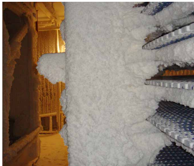
Nagromadzony lód ogranicza prędkość przepływu powietrza, zmniejszając wydajność układu.
